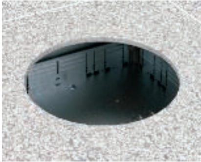
Укладка напольного покрытия Напольное покрытие уложить до монтажного отверстия для лючка GRAFT9.
