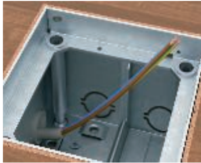
Подготовить соединительный кабель для розетки Подготовить соединительный кабель для розетки.
