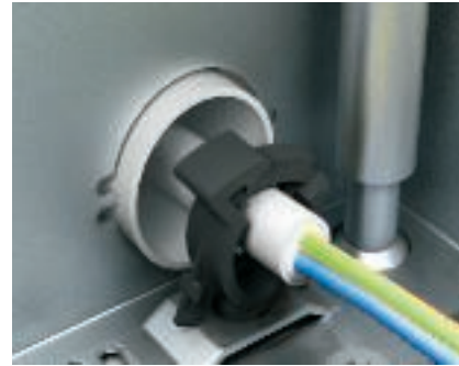
Монтаж фиксатора для разгрузки кабеля от натяжения Установить фиксатор для разгрузки кабеля от натяжения перед введенной электро-монтажной трубой (для подключения розетки).
