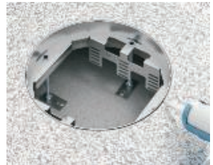
Укладка напольного покрытия вокруг кассетной рамки Уложить напольное покрытие вокруг кассетной рамки. Оставшийся зазор между напольным покрытием и кассетной рамкой уплотнить с помощью соответствующего материала.
