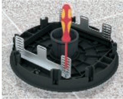
Монтаж держателя Прикрепить монтажную рамку с помощью винтов перед монтажом лючка GRAFT9.
